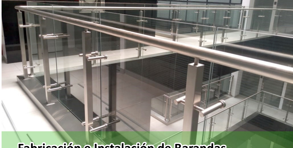
Fabricación e Instalación de Barandas
