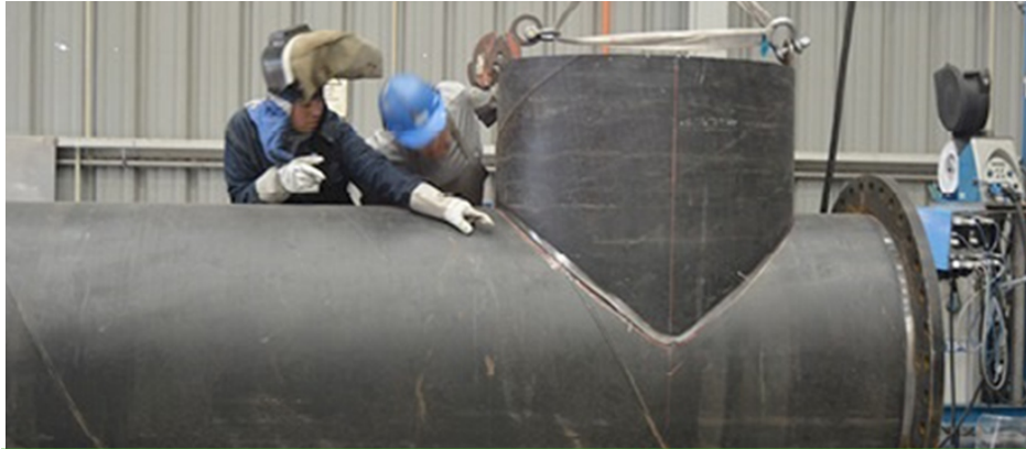
Pre-Ensamble de Tuberías de Aleación
